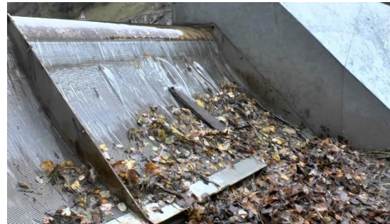
Grilles d'entrée canal et/ou chambre ichtyocompatibles COANDA
